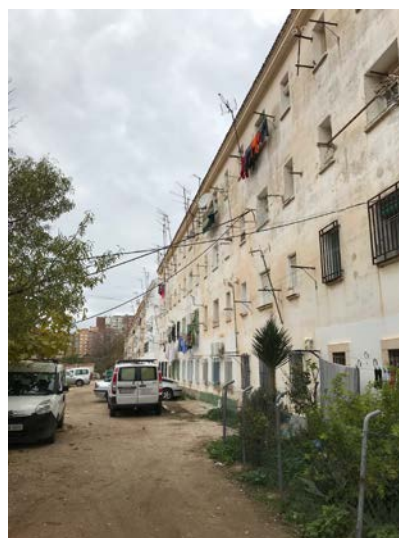
Fachada interior a patio de manzana. Acumulación desordenada de vehículos.
